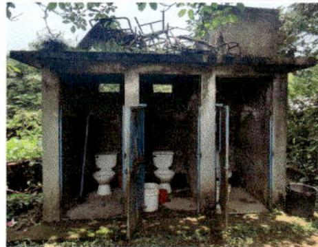
Foto 10: SUSTITUCIÓN DE LAS TASAS SANITARIAS DEL MODULO DE BAÑOS, CAMBIO DEL DEPOSITO DE AGUA, Y SUSTITUCIÓN DE TUBERÍA DE LINEA PRINCIPAL
