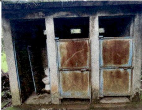
Foto 5: MANTENIMIENTO A PUERTAS Y PAREDES DE MODULO DE BAÑOS (PINTURA, MARCOS, PASADORES)
