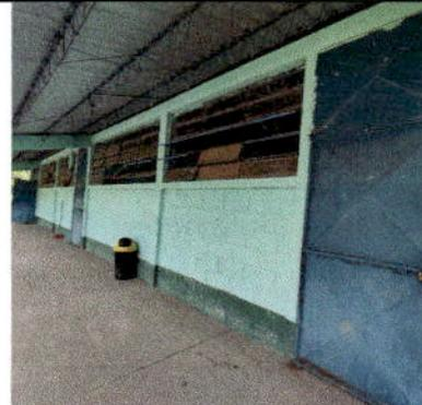
Foto 4: MANTENIMIENTO A PUERTAS DE AULAS (PINTURA, CAMBIO DE MARCOS)
