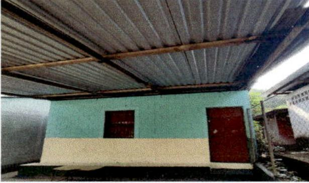
FOTO 13: SUSTITUCIÓN DE DE SOPORTE DE MADERA POR METAL
