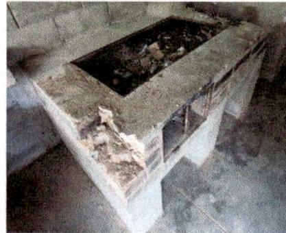
Foto 11: SUSTITUCIÓN DE PILA DE CEMENTO POR PILA DE CONCRETO REVESTIDA DE AZULEJO
